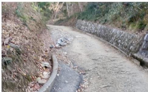
管理用道路の補修
