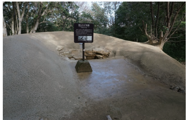
工事完了状況（前山A47号墳）
