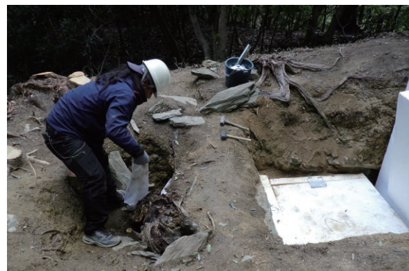
軽量盛土（EPS）による石室埋戻し状況（前山B 191号墳）
