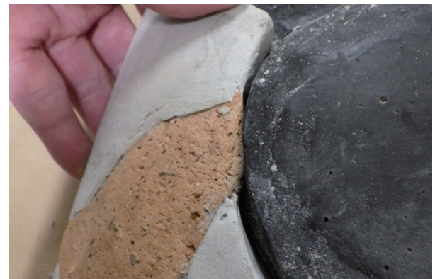
写真12 基部と既存支持具の密着状況
