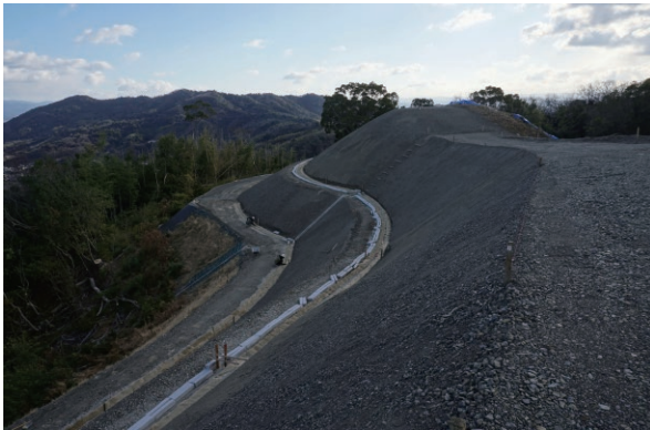
天王塚古墳 墳丘北側盛土施工状況
