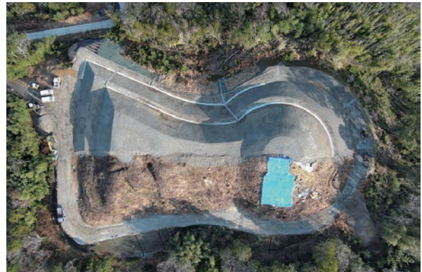
天王塚古墳 工事完了状況
