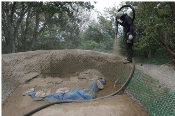
墳丘盛土（真砂土舗装）施工状況（前山A 47号墳）
