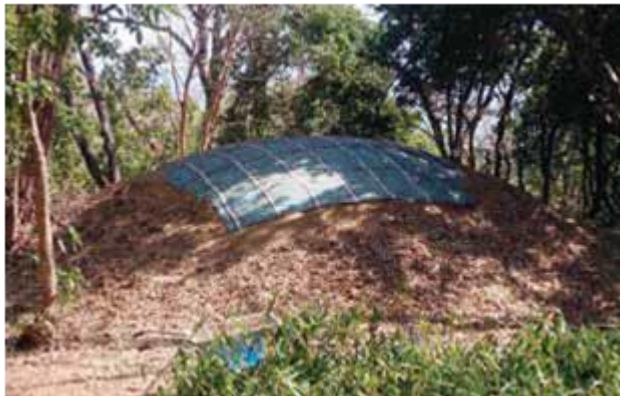
古墳修景工事完了状況
