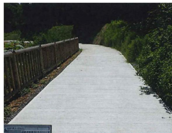
天王塚古墳連絡道路設置工事状況 2
