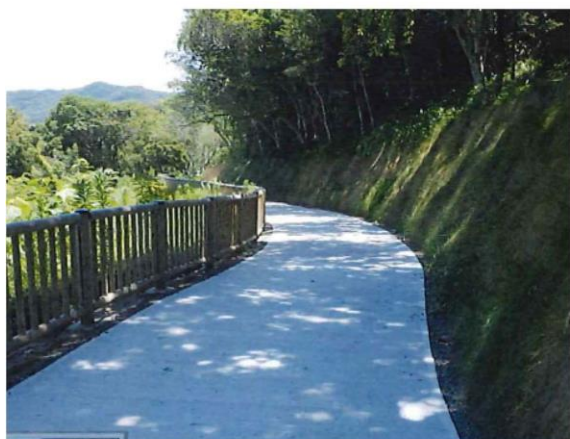
天王塚古墳連絡道路設置工事状況 1
