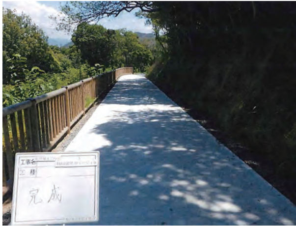
写真1 天王塚古墳連絡道設置工事
