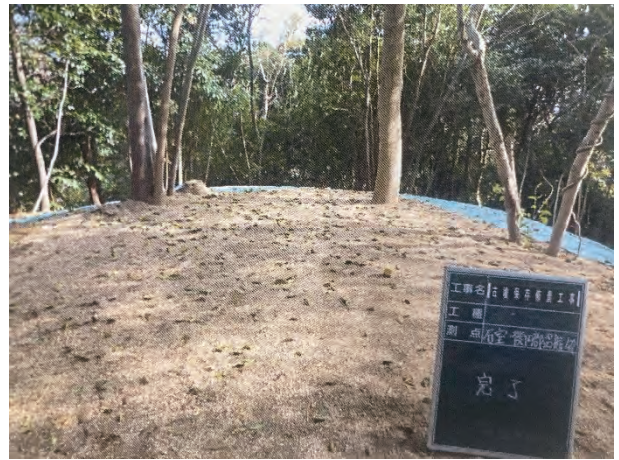
写真2 大日山1号墳修景工事
