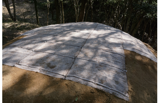
写真2 前山 B132 号墳保存修景工事
