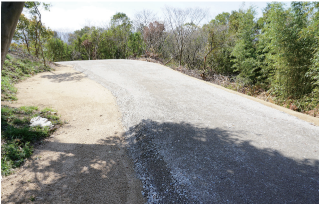
写真1 天王塚古墳連絡道設置工事
