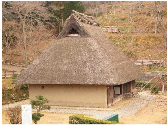
写真 1 2. 県指定文化財 旧小早川家住宅
