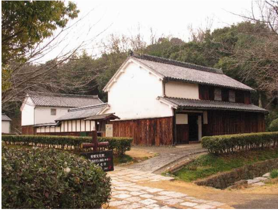
写真 1 1. 重要文化財 旧柳川家住宅
