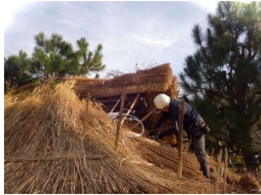
煙出し部分の噴き上げ
