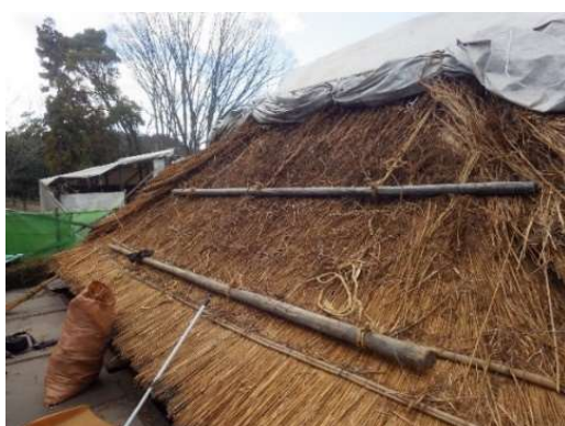
茅葺きを解体している
